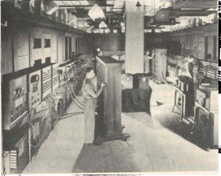
ŞEKİL 56 Elektronik Nümerik Entegratör ve Hesap Makinesi (ENIAC), 1945.
