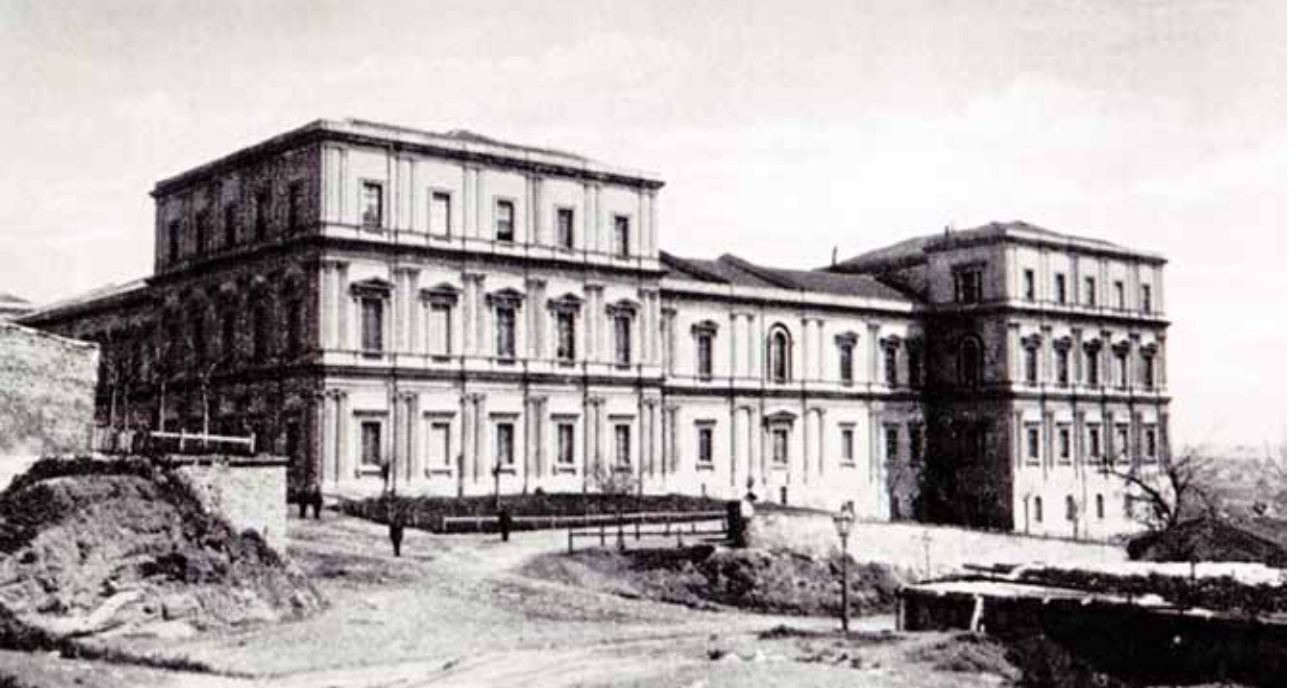
Günümüzde İstanbul Teknik Üniversitesi Mimarlık Fakültesi binası olarak hizmet veren Taşkıışla
