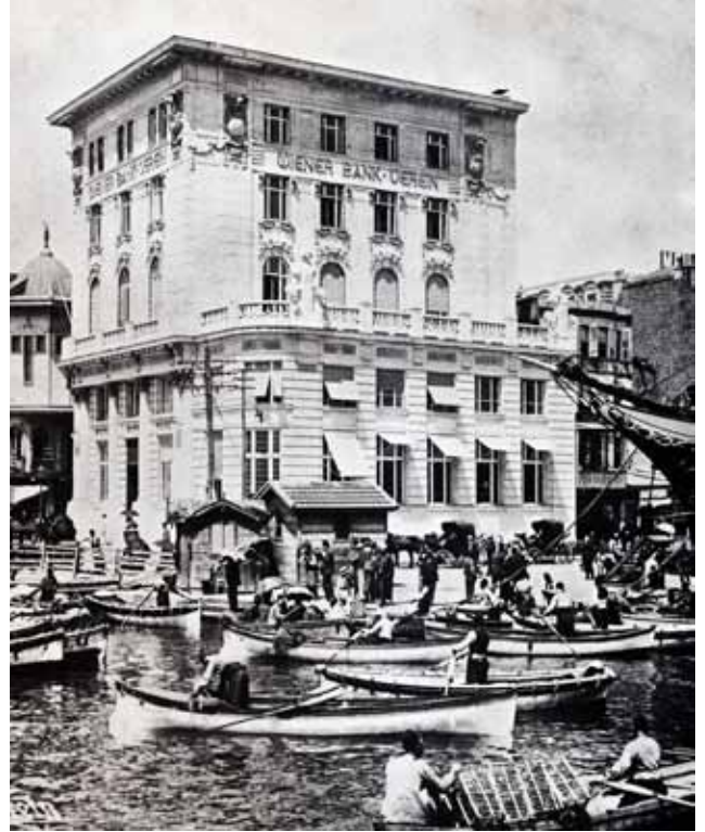
20. yüzyılın başında Karaköy İskelesi’nde günümüzde Ziraat Bankası’nın kullandığı “Wiener Bank” binası
