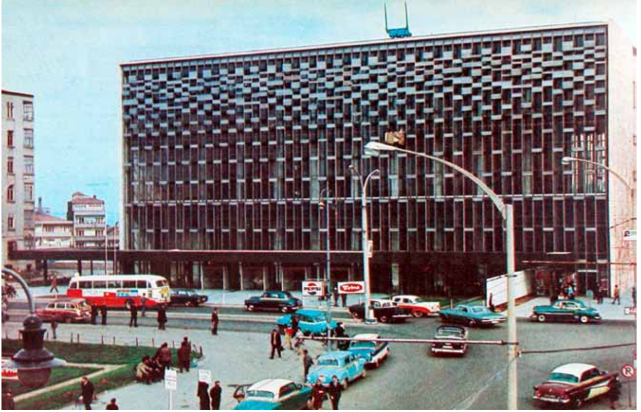
27 Kasım 1970'te çıkan yangın sonucu harap olan İstanbul Kültür Sarayı ya da sonradan aldığı adıyla Atatürk Kültür Merkezi (AKM)
