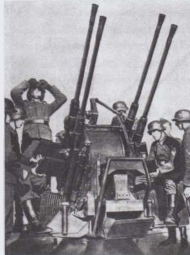
Yirmi milimetre kalibredeki dört namlulu alman uçaksavar silahı Flakvierling. Bu silah alçaktan uçan uçaklara karşı tasarlanmış olsa da yer hedeflerine, özellikle de piyade ve hafif zırhlı araçlara karşı çok etkili olduğunu ispatlamıştı.
