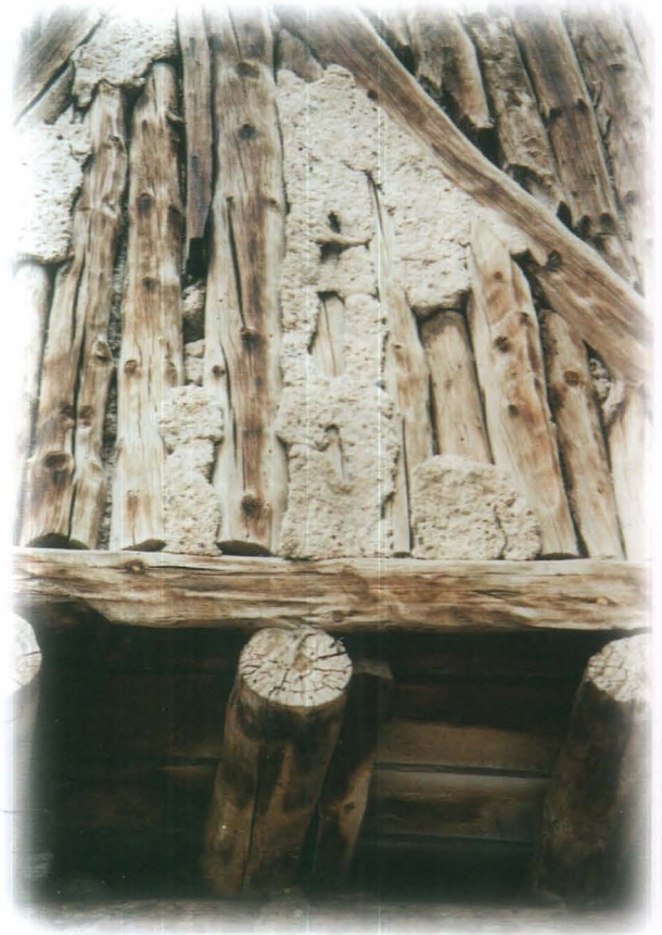
195 - 196 Ankara, Gdl'den dklmş sıvaları mimari' kuruluş ayrıntılarını izlememize olanak veren bir evin yan cephesinden ayrıntılar.
