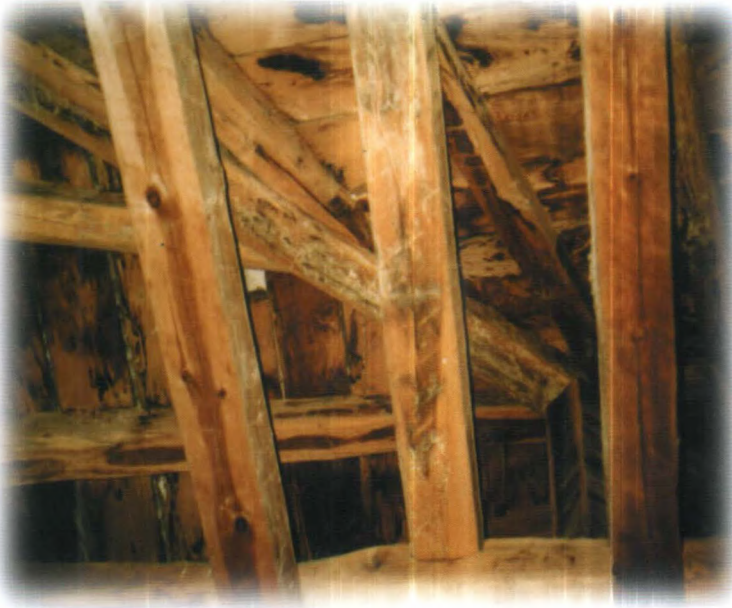
197 İnebolu, Başköy Camisi'nin onarım görmüş çatı kuruluşundan ayrıntılar.
