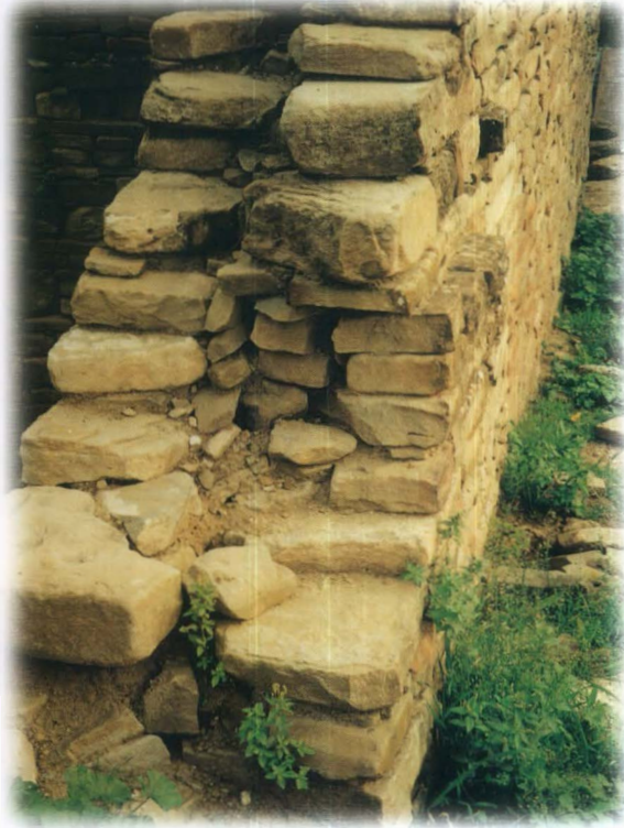
888 - 889 Adana, Karaisalı, Hacılar'dan taş ocaklı bir evden bir duvarının görünüşü ve aynı evin duvar örgüsünden bir ayrıntı.
