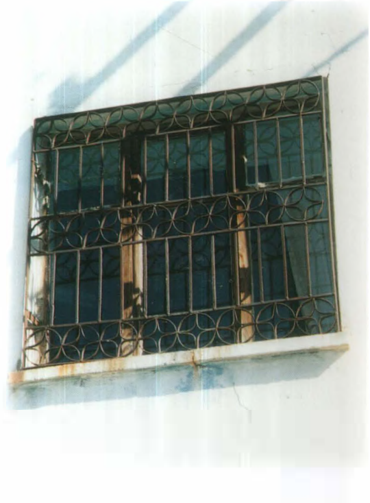
687 Kayseri, Develi'den bir pencere demiri.
