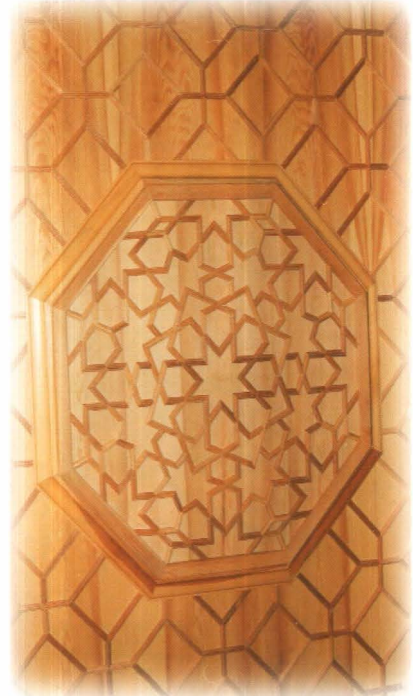
210 - 211 Kündekâri tekniğinin Mevlüt Çiller tarafından uygulanışı ve ustanın yaptığı bir kündekâri tavandan ayrıntı.
