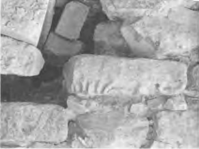
Resim 6: Duvar Örgüsünde Kullanılan Devşirme Malzemelerden Birisinin Görünümü (2009, S. Bellibaş / Efes Kazıları).
