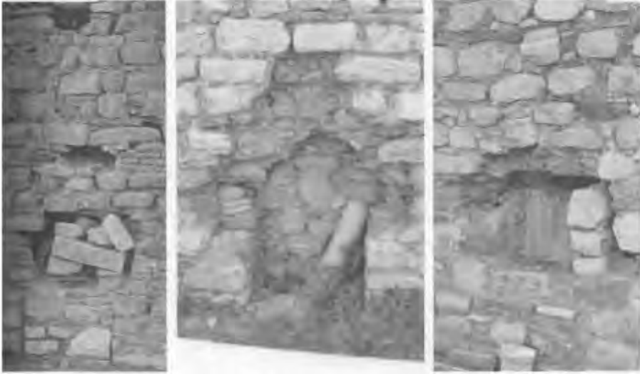
Resim 8: Cephelerde Kapatılan Pencere Açıklıkları (2009, S. Bellibaş / Efes Kazıları).
