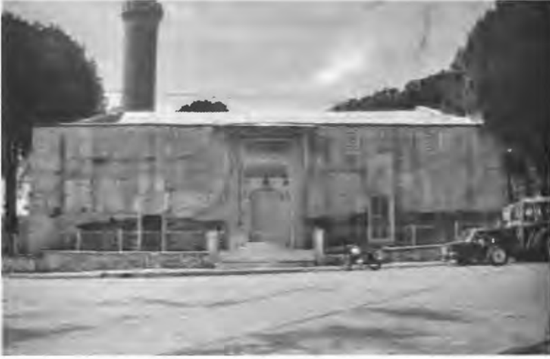
RESİM 1- Birgi Ulu Camii Doğu Cephesi
