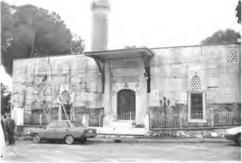
Resim 10: Birgi Ulu Camii, Doğu Cephe.
