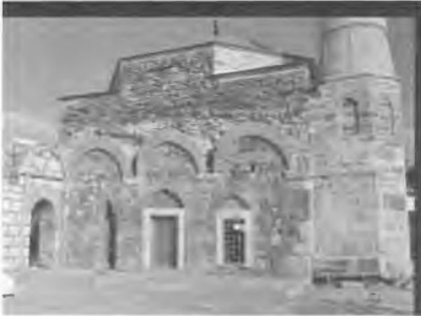
RESİM 16- İzmir Cüneyd Bey Camii kuzey cephesi
