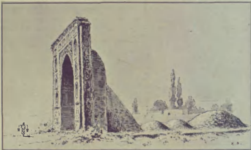
RÉSERVOIR A SAVEH.
