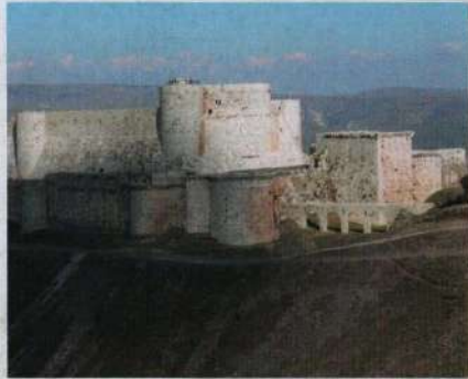
Yukarıda fotoğrafı görülen Suriye'deki "Şövalyeler Hastanesi" 1142 yılında Krak des Chevaliers tarafından eski bir Arap kalesinin bulunduğu yere inşa edilen anıtsal bir tahkimattı
