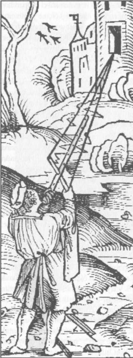
Şekil 33. "Geometrie practice" (Geometri uygulaması): Jakop çubuğu ile uzaklık ölçümü (Gregorius Reisch, Margarita philosophica... , Basel, 1517). 55
