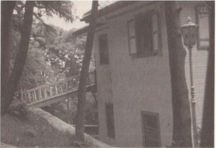
Aşyan'daki evi Kolej'e bağlayan merdiven.
