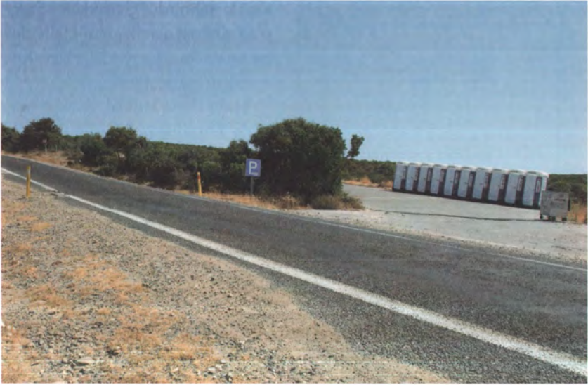
Bombasrtı siperlerinin 2007'deki durumu.
