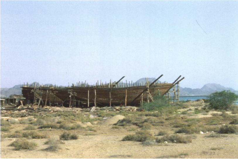
95. Kung limanının bulunduğu körfez boyunca dhow inşaatı.
