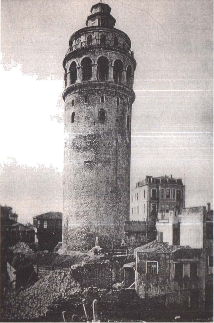
Şekil 1.45 Galata Kulesi etrafındaki yapılaşma, sur duvarlarının yıkımı ve kulenin sağ tarafında Pekmezyan apartmanı görülmekte.
