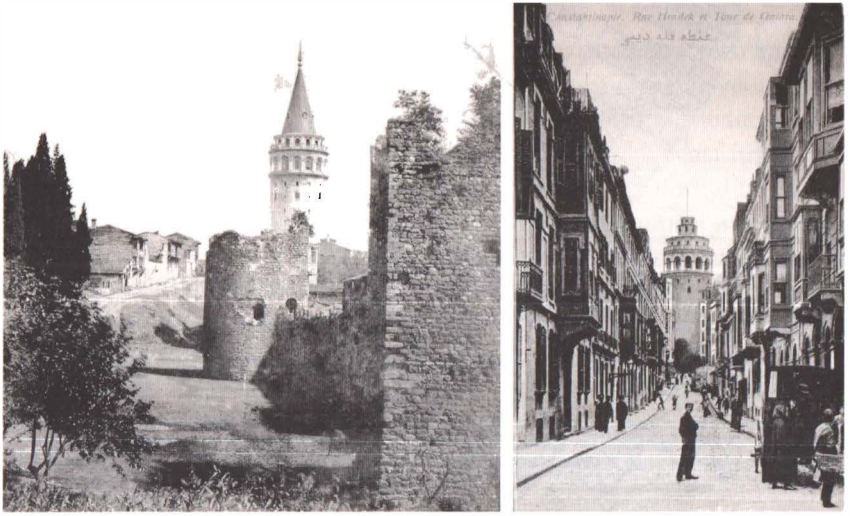
Şekil 1.32 Surlar yıkılmadan önce hendek ve yıkıldıktan sonra Büyük Hendek Sokak.
