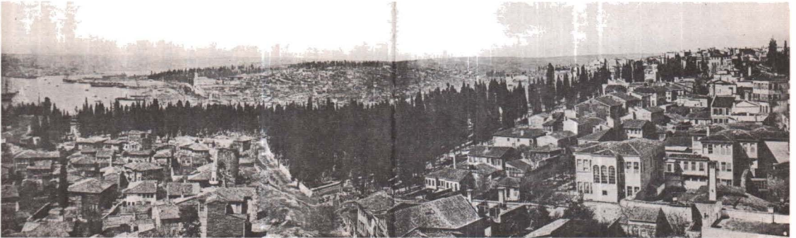
Şekil 2.3 Galata kulesinden surlar yıkılmadan ahşap yapılar, S. H. Eldem İstanbul Hatırası
