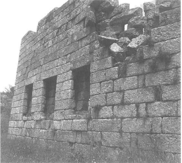
Res. 6 Isodom Rektogonal Örgü (Labraunda Andron Yapısı)
