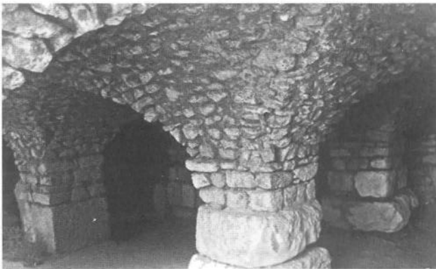
Res. 2 Pisidia Antiokheiası Hamam Kompleksi (?), Şekilsiz Taşlarla Örölmüş Harçlı Tonoz ve Duvarlar (Pisidia Antiokheiası Kazı Arşivi)
