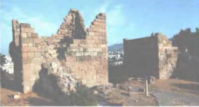
Myndos yoluna açılan Myndos Kapısı Batı Surları üzerindedir.
