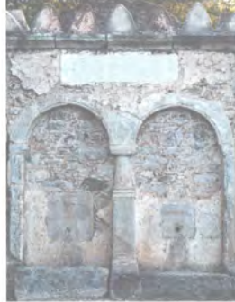
Yol kenarındaki çeşme yapısı.
