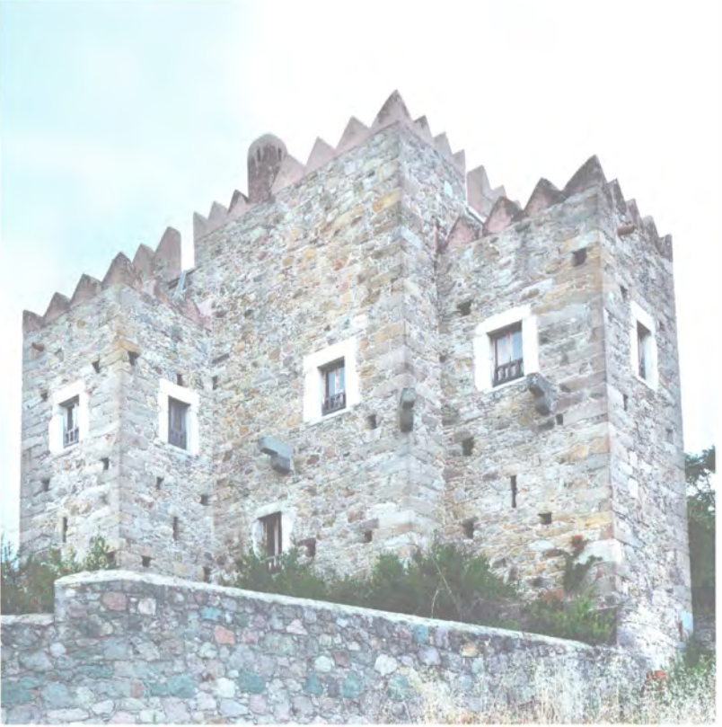
Ortakent'te görülen, Mustafa Paşa Kule Evi.
