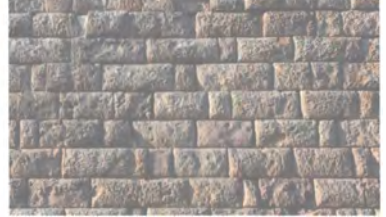
Myndos Kapısı isodomik duvar örgüsü.
