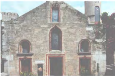
Şapelin ön cephesi.
