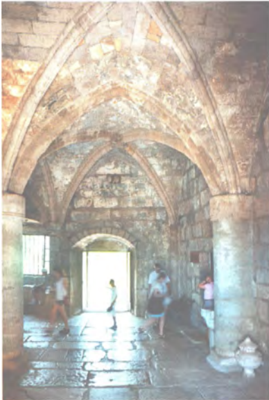
Fransız Kulesi girişindeki çapraz tonozlu yapı.
