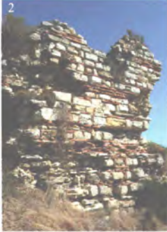
1, 2- Sestos yerleşimi üstündeki sur kalıntıları.
