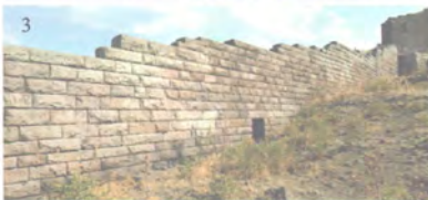
1- Kentin Doğu Surları. 2- Batı Kapısı'nın yer aldığı surlar. 3- Surların duvar örgüsü dikkat çekerek.
