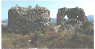
Harap durumdaki kalenin içinde kaçak kazı çukurları görülür.
