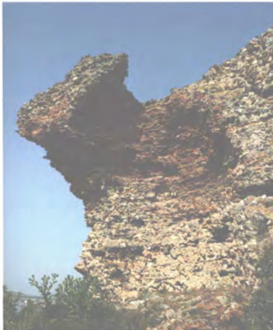
Sur duvarları yapımında moloz taş ve tuğla da kullanılmıştır.
