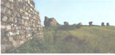
Altı yüz elli metre uzunluğundaki Geç Bizans Dönemi surlarının üzerinde yirmi dört kule bulunmaktaydı.
