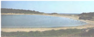
İç Liman'ın girişi erozyon nedeniyle kapanmış, liman göle dönüşmüştür.
