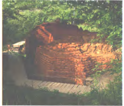
Kerpiç, kale duvarı.
