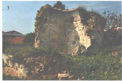
1, 2, 3- Seddülbahir Köyü içinde kale yakınında görülen yapılar.
