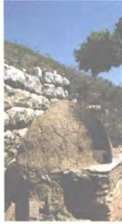
Sur duvarı bitişğine yapılmış ekmeek fırını.
