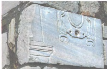
Kule yapımında kullanılmış devşirme, bezemeli mimari blok.
