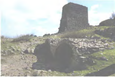
Akropol'ün kuzeyindeki sarnıç yapısı.
