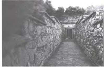
Koridorun genişliği aşağı kısımda 1,57 m. yukarı kısımda ise 1,11 m.dir. Yan duvarları sarımsı kum taşından örülmüştür.
