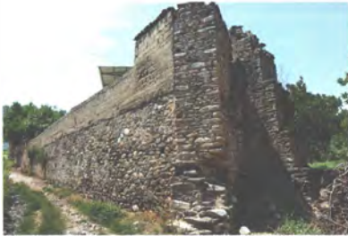
Kestel Köyü içindeki tonozlu duvar yapısı.
