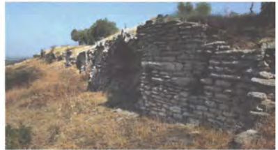
Yerleşimin bulunduğu teras duvarı.
