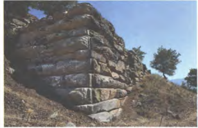
Yerleşimdeki teras duvarı.
