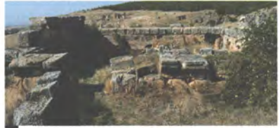
Kentin içme suyunun dağıtıldığı su deposu.
