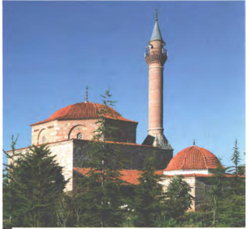
Çivril İlçesi, Emirhisar Kasabası, Dedeköy Camisi. 15.-16.yy.
