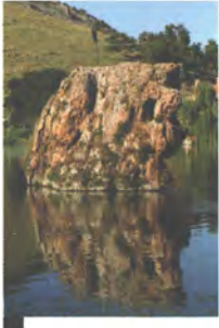
Kocası kaynağı göleti içinde görülen Tympanumlu Su Dağıtım Terminali.
