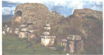
Stadyumun kuzey oturma sıraları tonozlu bir alt yapı üzerindedir.
