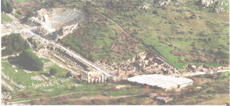
Yamaç Ev 2 kompleksi, 2000 yılında çatıyla kaplanarak koruma altına alınmıştır.
