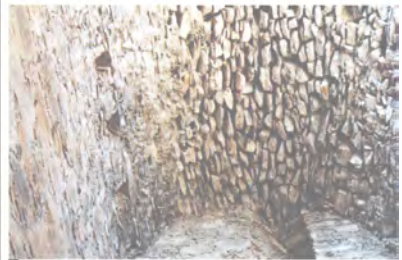
Kuzeydoğu kulesinin iç görünümü.
