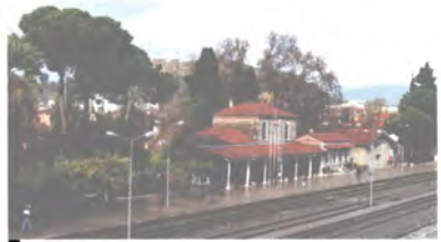
Selçuk gar binası.
