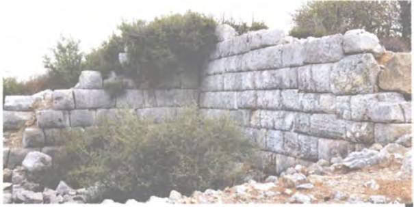
Notion'da sur duvarı.
