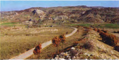
Güney surları. Kentin güneyinden doğu yönüne inen surlar.
