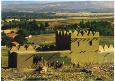
Aşağı Şehir surlarının rekonstrüksiyon çalışmaları. Temmuz 2006.
