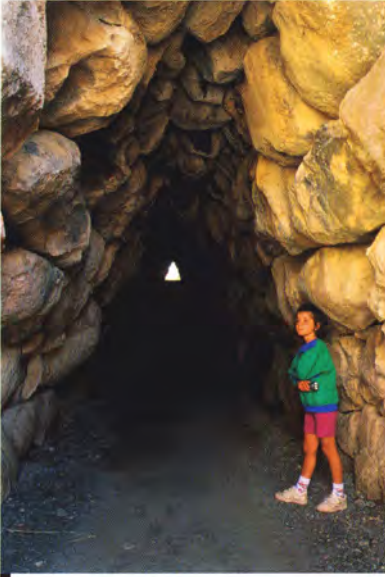
Yer Kapı'daki potern (tünel).
