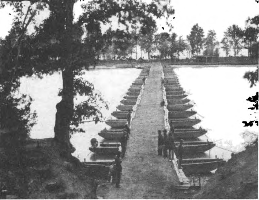
64.1. Ponton Köprü. Ponton köprüler yüzyıllar boyu askeri stratejinin bir parçası olmuştur; bu ponton köprü Amerikan İç Savaşı sırasında, Virginia'daki James Nehri'nde kurulmuştu. Fotoğraf, Melford Historical Society Collection/CORBIS
