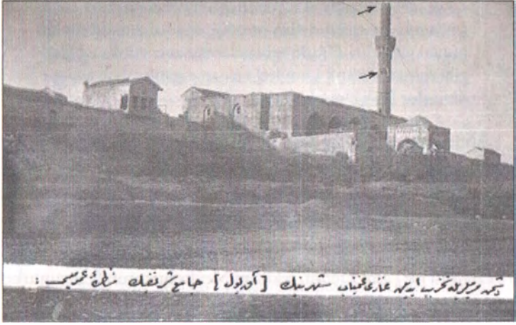
Fotoğraf- 1 Düşman mermileriyle tahrip edilen Akyol Camisi. 89
