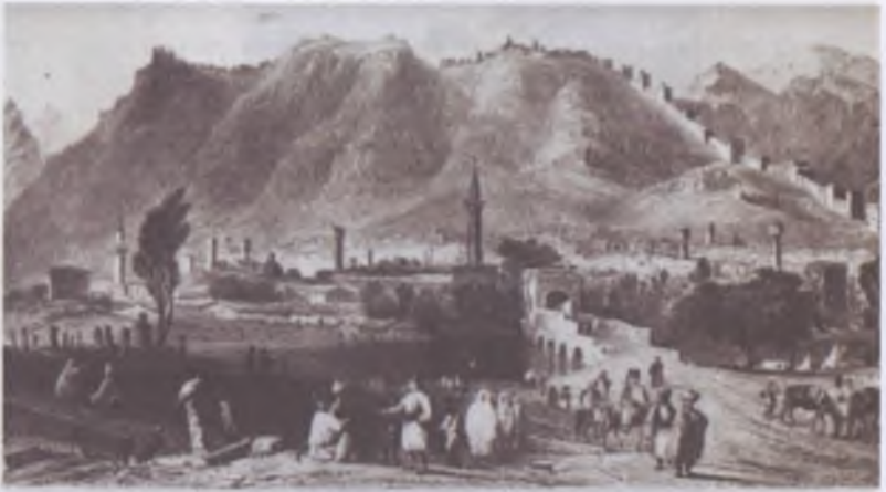
Asirnak'dan Antakya'nın görünüşü; ön planda müstahkem köprü; sağda haçlıların şehre girdikleri sur kesimi; yamaçta şehrin binaları
