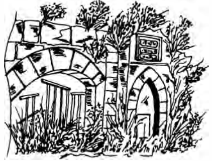
Metruk arsa içinde Esekapi (İbrahim Paşa) mescit ve medresesinden geriye kalan bazı bölümler.
