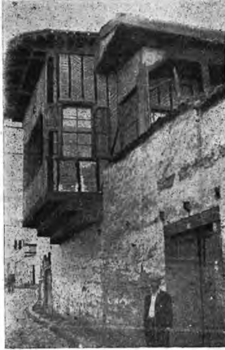
49. Yenice sokak 50 No. lu evden bir görünüş
