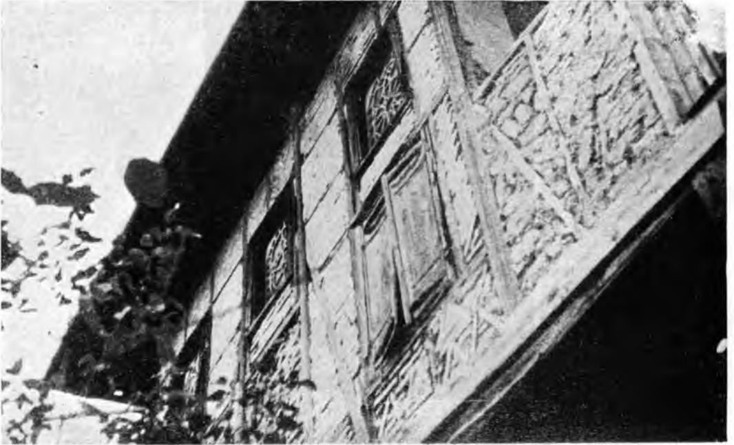
42. Kasap Mustafa ağa evi - Ankara, Filiz Sok. 7 (Avluya bakan oda cephesinin görünüşü.)
