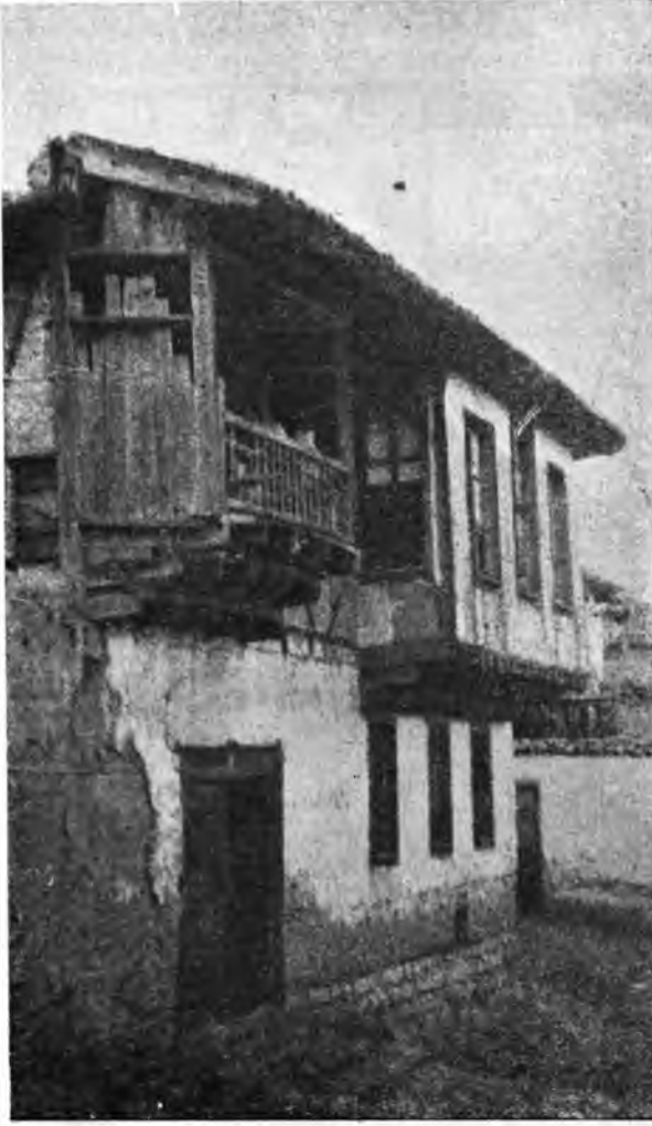
32, 33. Merdivenli sokak 17 - Ankara
