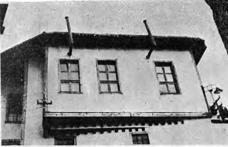
76. Gayri muntazam arsada üst katın muntazam ve kaim zaviyeli plân verebilmesi için teşkil edilen bir çıkma şekli
