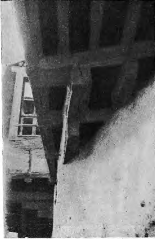
85. Büyük bir köşe kırması konstrüksiyonunu gösterir fotoğraf
