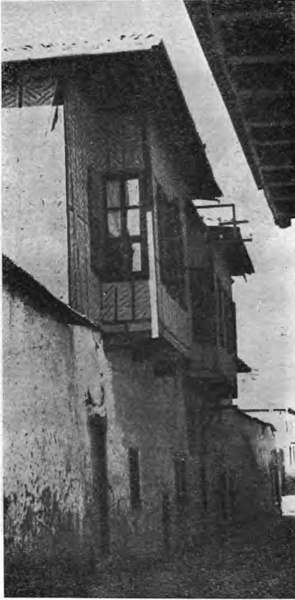
100. Çıkmaların 19. asırda aldığı fakir konstrüksiyon şekli
