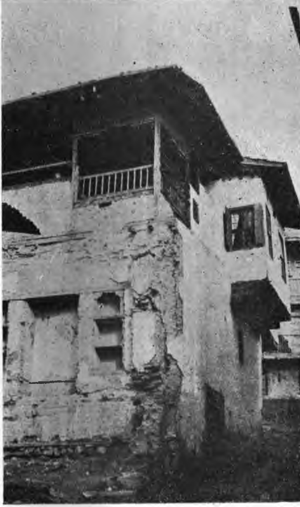
128. Kızılcama mahallesi, Hamaralar sokağında bir ev. (Yıkılan bitişik evin oda içi yerli dolap ve rafları görülmektedir.)
