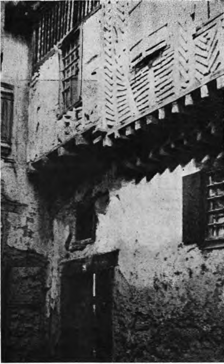
122. Hamamarkası sokağı 27 - 29, Ankara « H a y a t » ın sokak yüzü cihetine parmaklıkla kapanışı, ahşap parmaklık ve ahşap kapaklı asma kat penceresi detay fotoğrafı.
