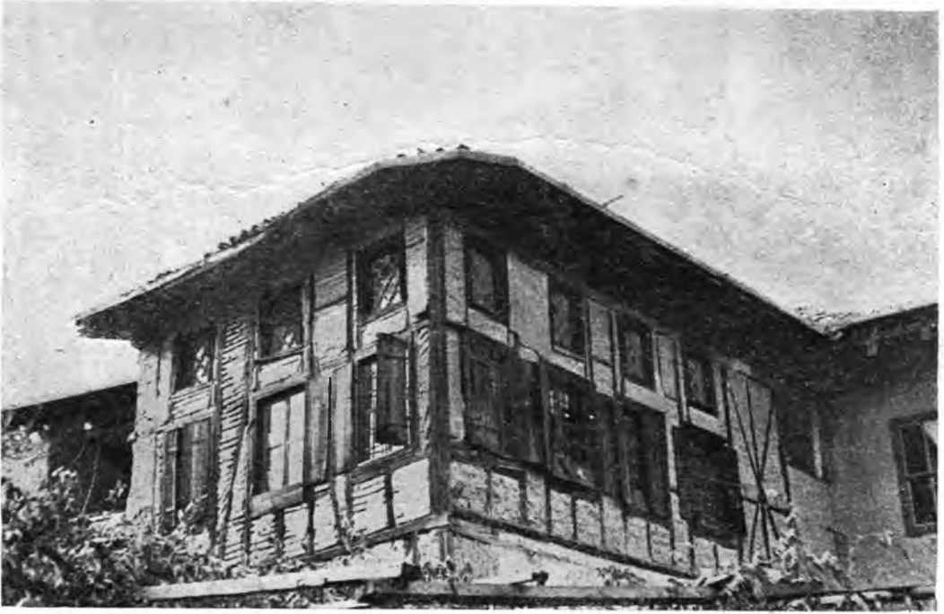
103. Bir Ankara evinde karakteristik divan hane (kabul odası) dış cephesi - üst pencereler alçı tezyinatlıdır. Hamamönü - Ankara
