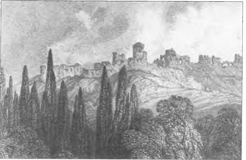
12 b) Smyrna'daki Kervan Köprüsü'nden hisarın görünümü.
