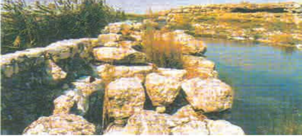
Böğet Barajı, Aksaray.
