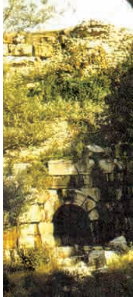
Örükaya Barajı, Çorum.
