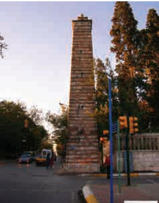
a- Kapıağası Su Terazisi, İstanbul.
