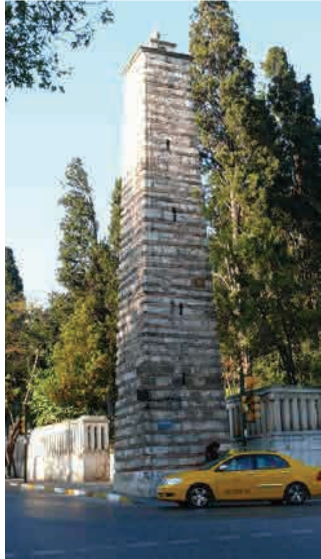
a- Kasımpaşa Su Terazisi, İstanbul. b- Duvardibi Mevkii Su Terazisi, İstanbul.
