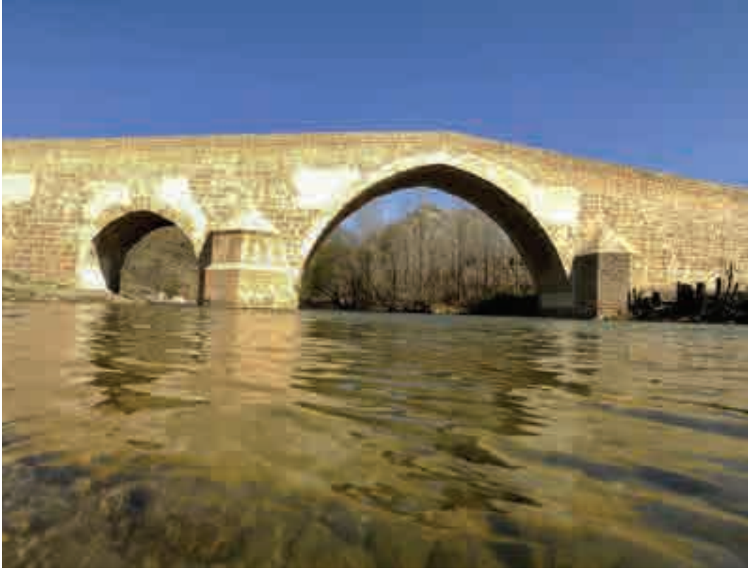
Haburman Köprüsü, Çermik/Diyarbakır.
