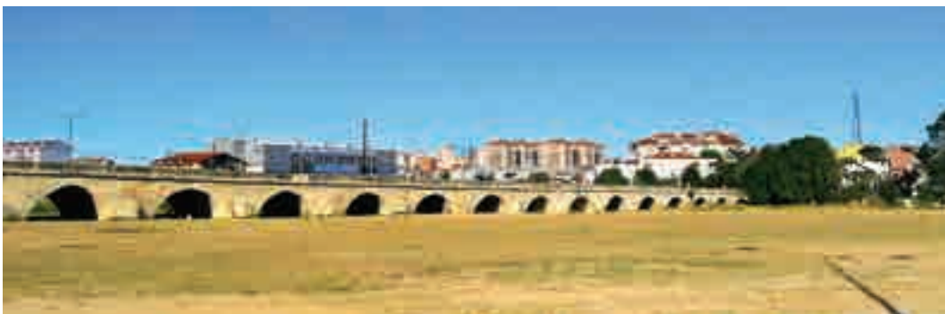
Mimar Sinan Köprüsü, Silivri/İstanbul.
