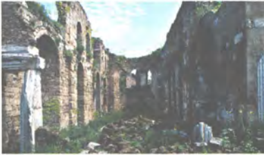
Kesik Minare olarak bilinen yapı yörede Korkut Cami ya da Cumanın Cami olarak da bilinir. İlk yapım evresi 5.yy'a dayanan yapı bazilika planlı bir Bizans kilisesidir. Yapının Aitalla Kentinin katedral kilisesi olabileceği düşünülmektedir. Yapı 36x27 m. boyutundadır.
