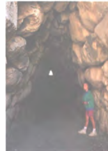
Yerkapı'daki potern (tünel).
