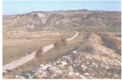
Güney surları. Kentin güneyinden doğu yönüne inen surlar.
