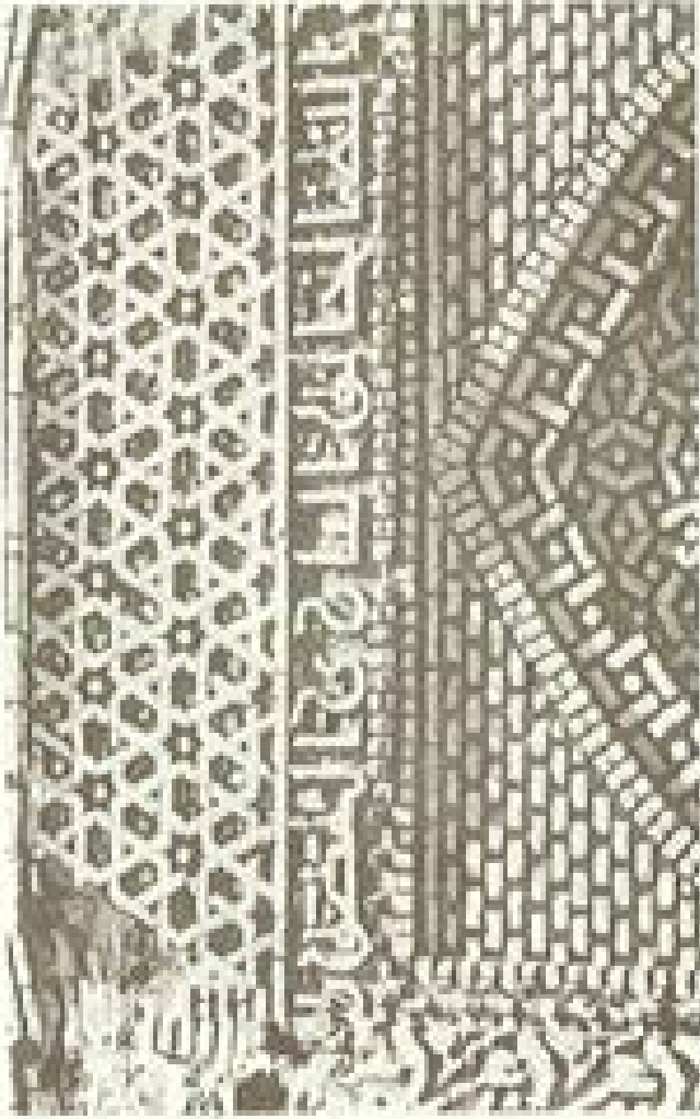
277. I.Harrekan Kumbet'in yedinci cephesinden detay
