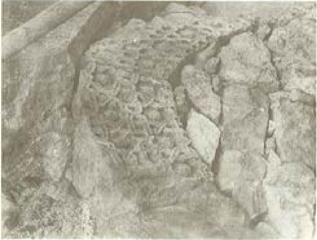
206. Divriği Ali Yusuf Türbesinden bir duvar
