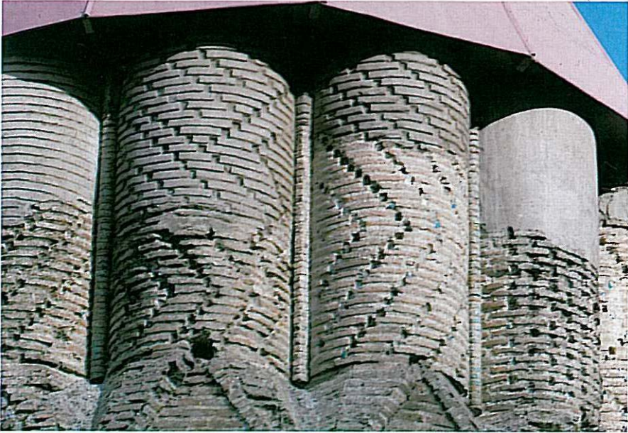
Resim: 44 - Akşehir Seyit Mahmut Hayrani Türbesi tuğla ve sırlı tuğla işçiliği (1268).
