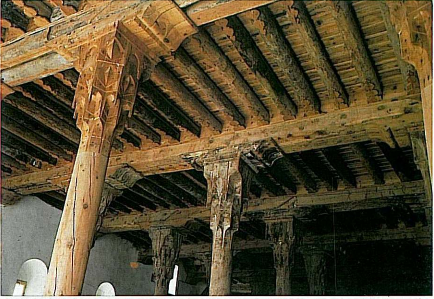
Resim: 101- Afyon Ulu Camii'nde ahşap konsollar, kirişler, sütunlar ve sütun başlıkları (1273)
