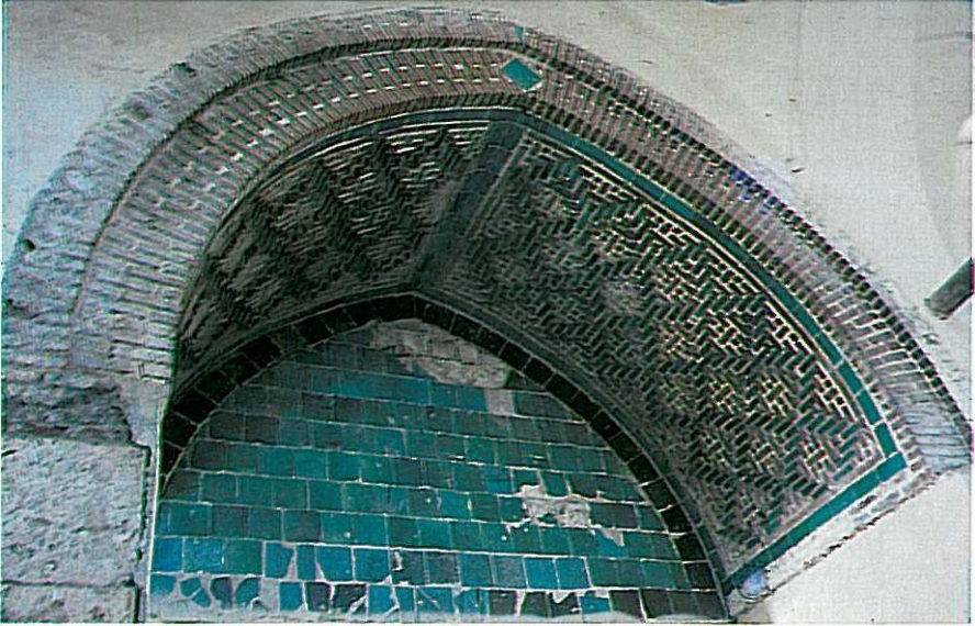
Resim: 41 - Amasya Gök Medrese Camii Türbesi kemerinde sırlı tuğla ve tuğla işçiliği (1266). Brick and glazed brickwork at the türbe door of Amasya Gök Medrese Mosque (1266).
