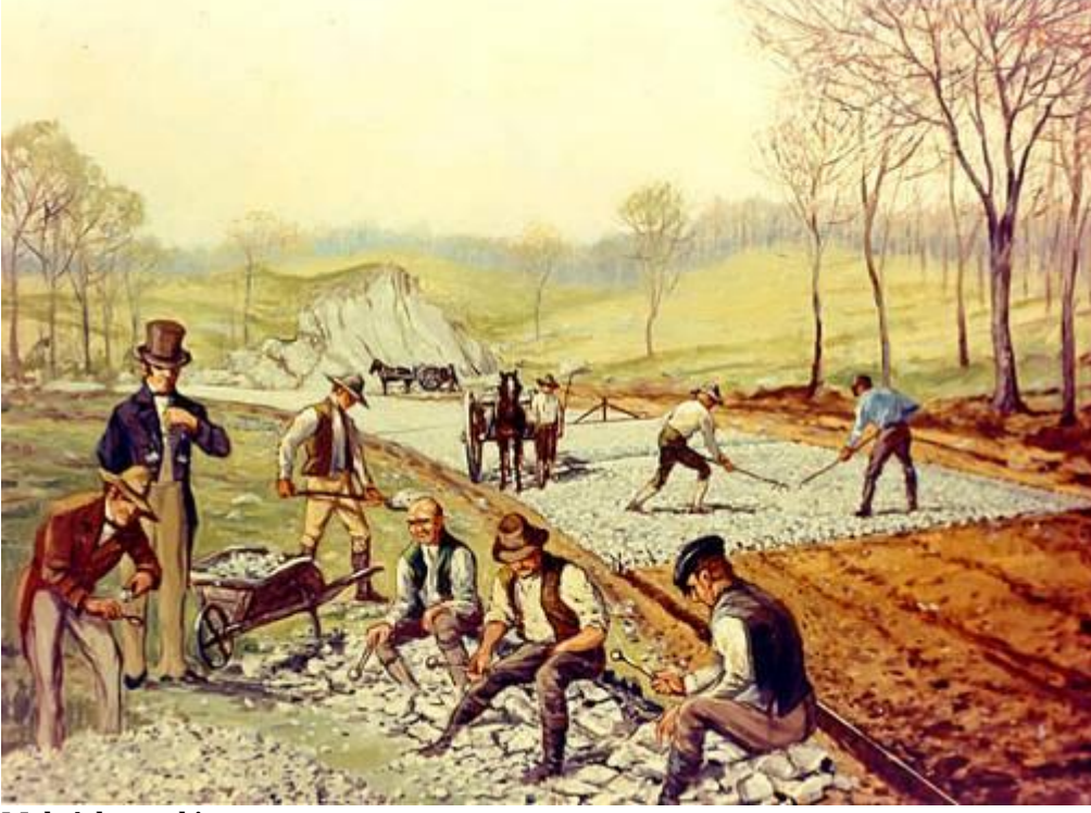
Mak Adam yol inşaatı
