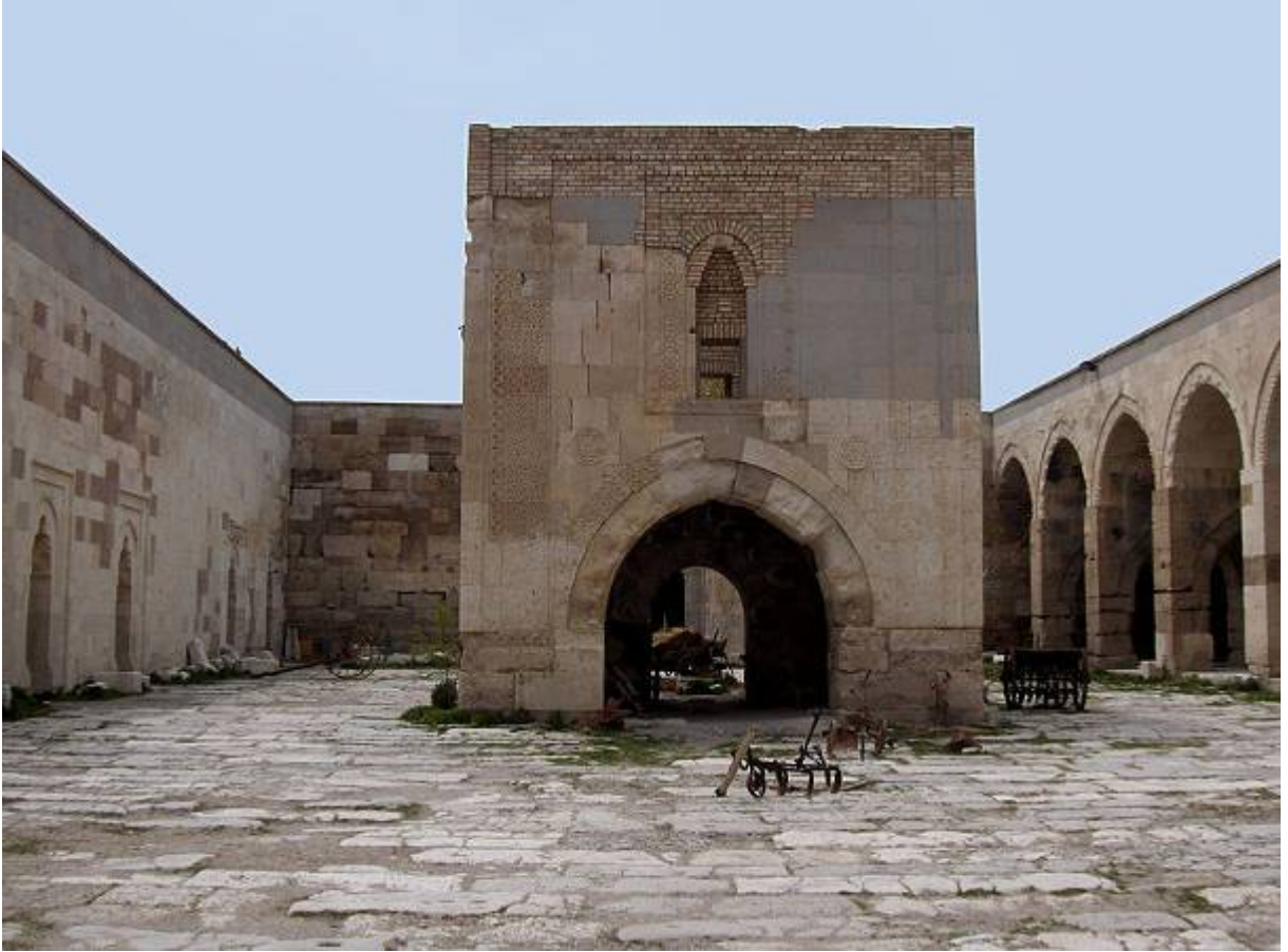
Aksaray Kervansarayı içi
