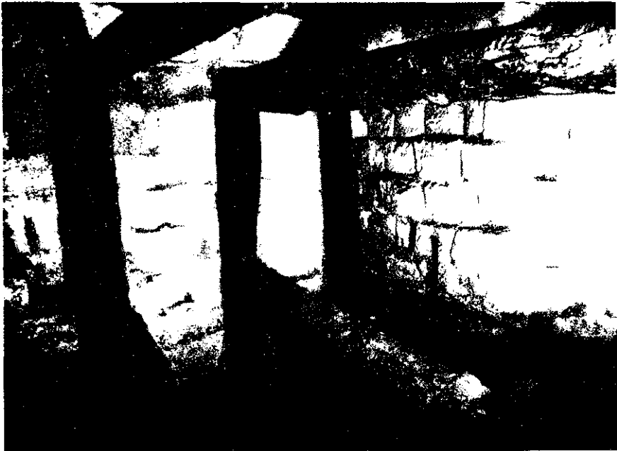
Şekil 99 Eğik Piramit: Üst mezar odasının duvarlarını destekleyen dikmeler ve kirişler.
