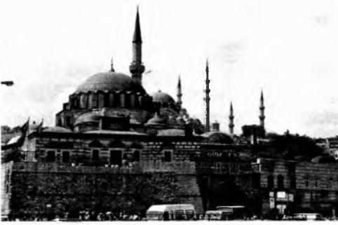
Rüstem Paşa Camii
