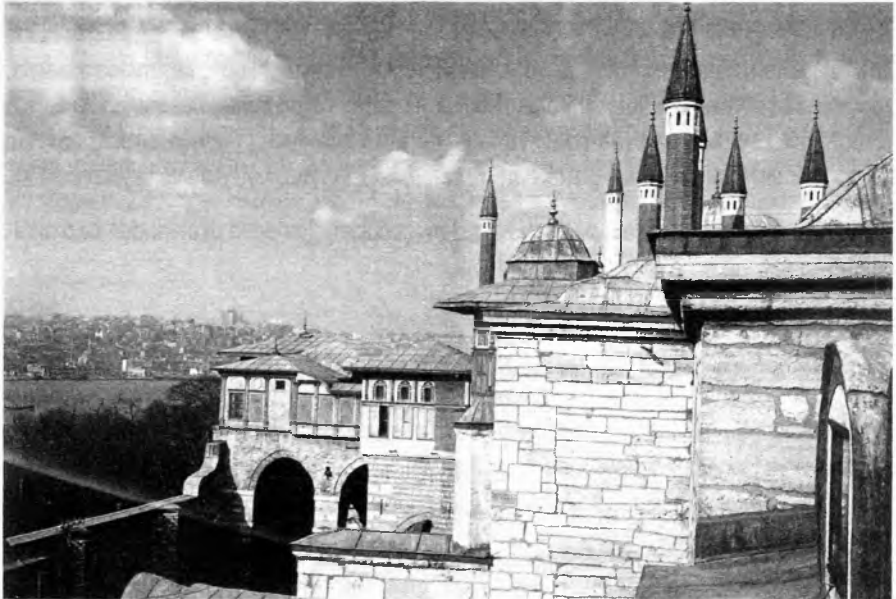
Topkapı Sarayı harem dairesinin dış cephesi
