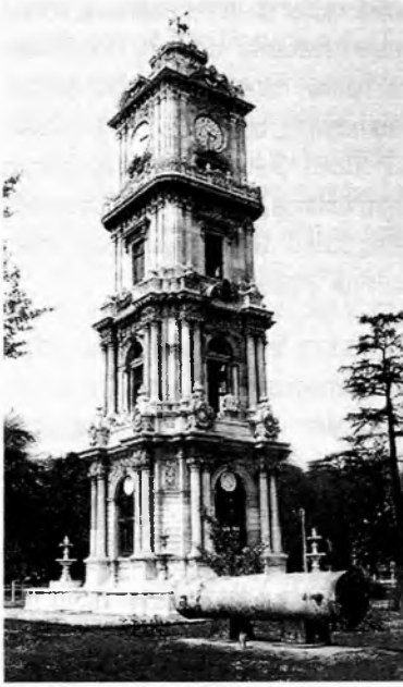
Dolmabahçe saat kulesi
