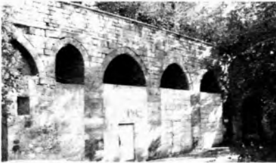
Damat İbrahim Paşa tarafından Nevşehir'de yaptırılan İbrahim Paşa kervansarayı
