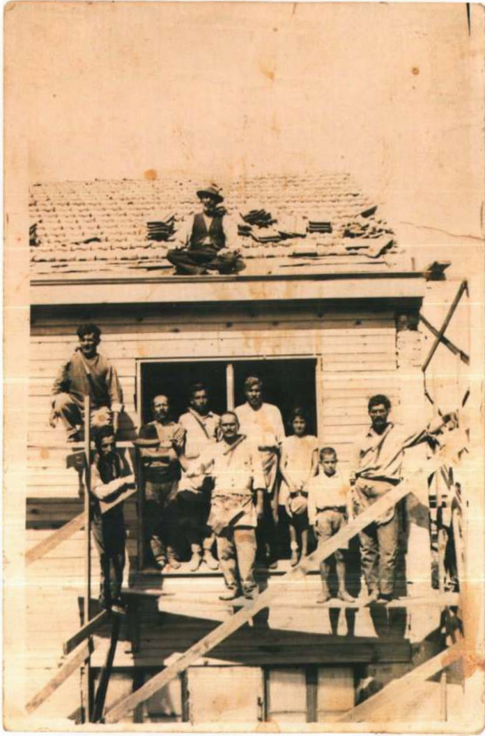
1920'lerde Heybelada'da altmışa yakın marangoz ve taş – duvar ustası vardı. 1894 depreminden sonra evlerin tamamına yakını altı kagir üstü ahşap olarak inşa edilmekteydi. Resimde çatının üzerinde Avram Lazarako. Aşağıda sağda Koço Mayıs ve Yanulî Darmis
