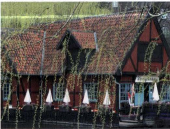
34.02 : Karlı bölgelerde yapıların damları kar tutmamaması için dik yapılır. (Fotoğraf : Özer Kanburoğlu)
