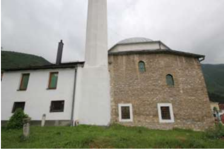
Fotoğraf 4: Hasan Ağa Camisi Batı Cephesi
