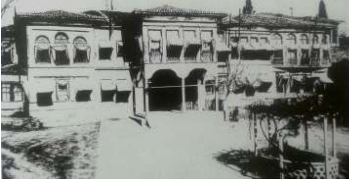
Fotoğraf 4: Eski Hükümet Konağı 45
