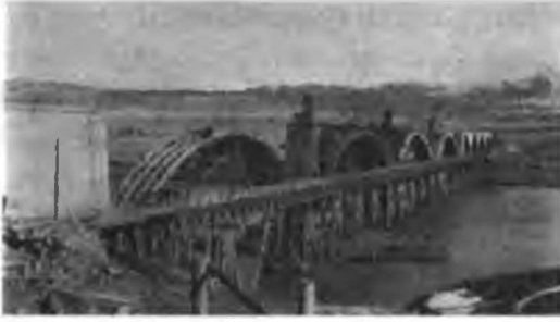
Fırat Nehri Üzerinde Demiryolu Köprüsünün Yapılışı
